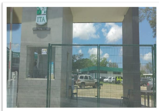
Figura 23. Caseta de vigilancia y portón principal.
