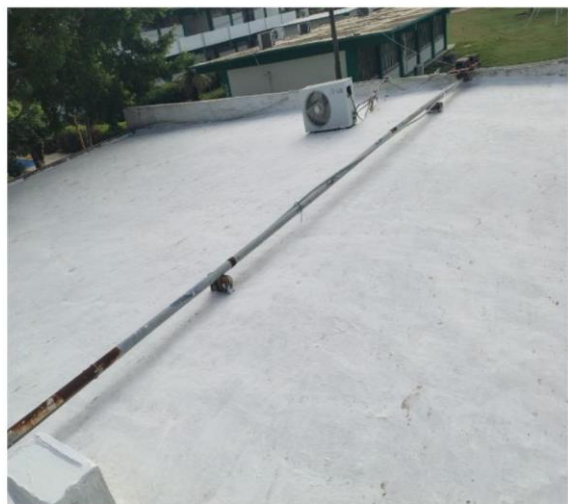
Figura 62-63. Impermeabilización de edificios del TecNM Altamira
