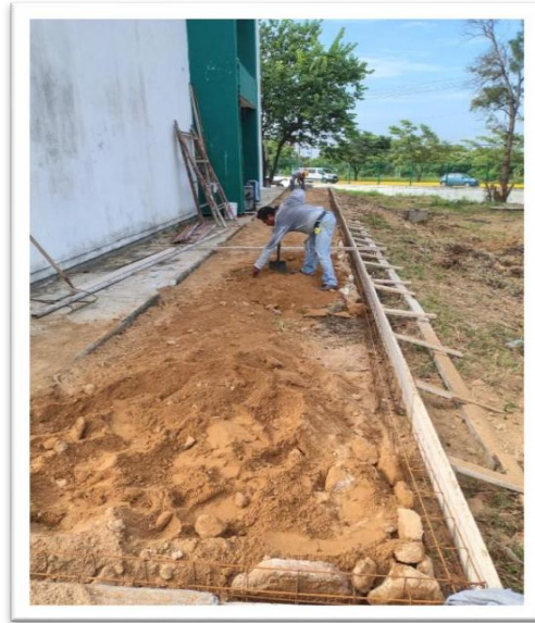
Figura 51 y 52. Resanado y elaboración de banquetta edificio D del TecNM Altamira
