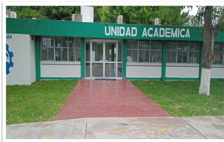
Figura 67-69. Elaboración de banquetas en edificio académico del TecNM Altamira
