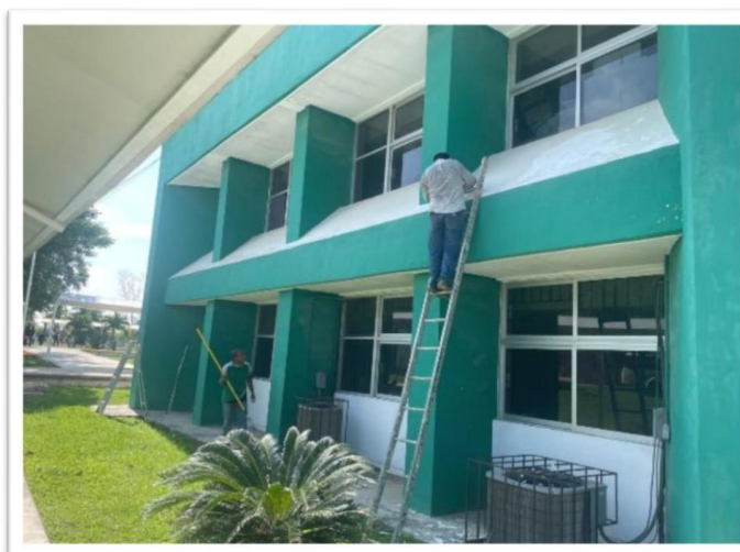
Figura 64-66. Mantenimiento a aulas de clases del TecNM Altamira
